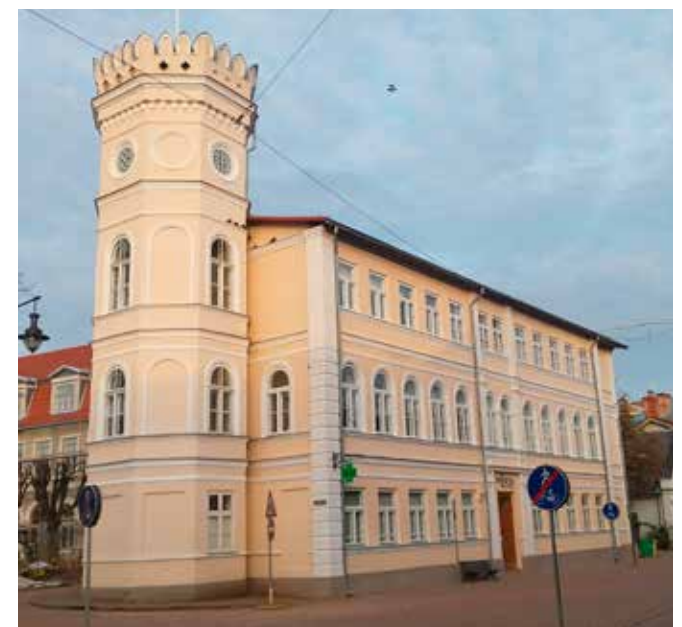
Liepājas ielas 37 ēka pēc rekonstrukcijas.
