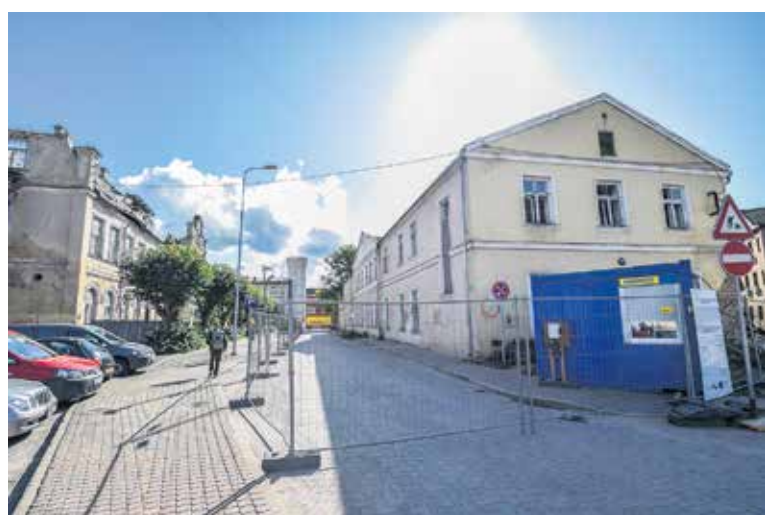
Uzsākti būvdarbi Kuldīgas Mākslas un radošā klastera izveidei Kuldīgā (Kalpaka ielā 2, 4 un Liepājas ielā 39). Pēc ēku pārbūves un skvēra labiekārtošanas te plānots izveidot starptautisku laikmetīgas augstākās izglītības centru.
