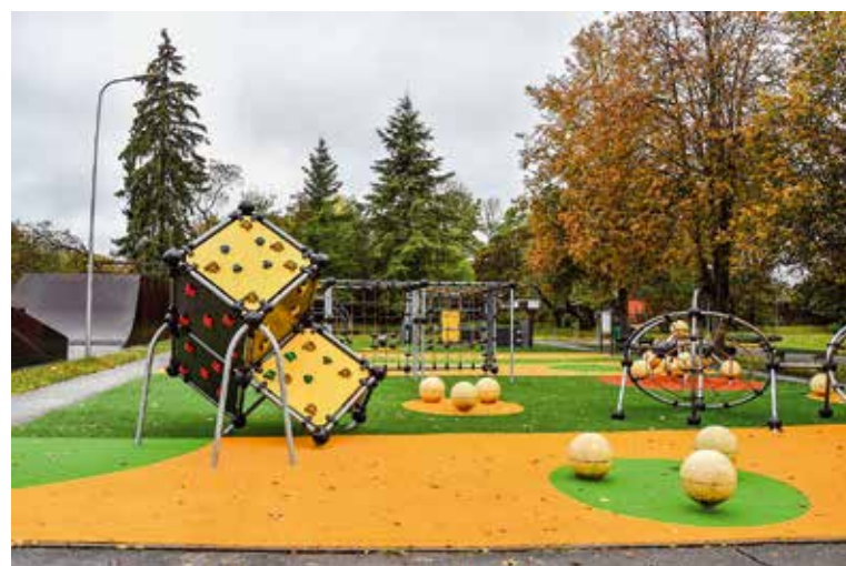
Noslēgusies seguma atjaunošana parkūra laukumā Estrādes parkā. Te nomainīja bojāto mākslīgā zāliena segumu un triecienabsorbējošo slāni, kā arī papildināja to ar kvarca smiltīm.
