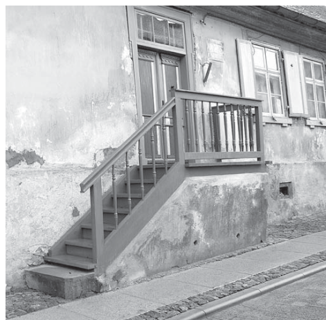
Vēsturiskais ieejas komplekss ar kāpņu laukumu un virpotām margām ēkai Kalna ielā 15 atjaunots pēc vēsturiskajām fotogrāfijām.
