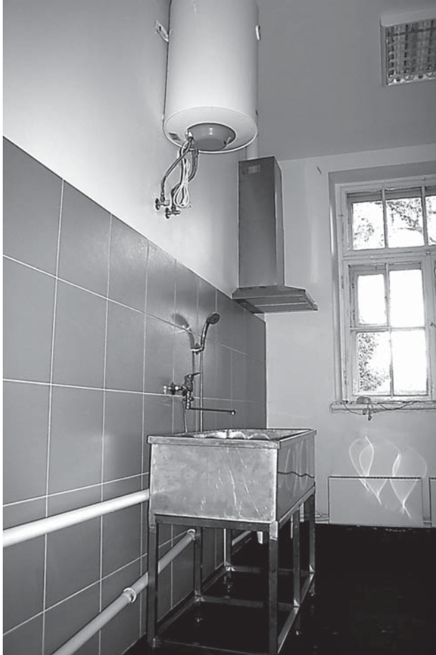
Kādreizējā skolotāju istaba Kuldīgas mākslas skolas otrajā stāvā pārveidota par laboratorijas telpu ar speciālu izlietni ar skābi apstrādātu grafikas darbu mazgāšanai un skābju glabājamo tvertni, bet sienas pretējā pusē ir vieta fotogrāfiju attīstīšanai.
