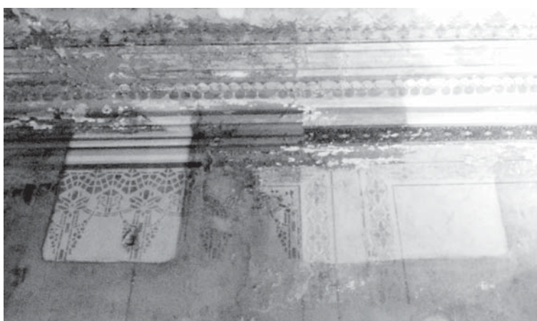
Attīrītais kontrollaukums atklāj sienas un griestu ieloces dekoratīvo krāsojumu. Sienas augšējā daļā pa visu telpas perimetru iet plata, stilizēta augu un abstrakta ornamenta josla. Sienas pamattonis ir gaiši zaļš.
