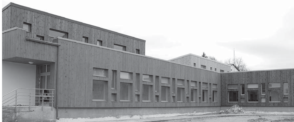
„Ābelītes” bērni atgriežas gaišās un skaisti izremontētās telpās.
